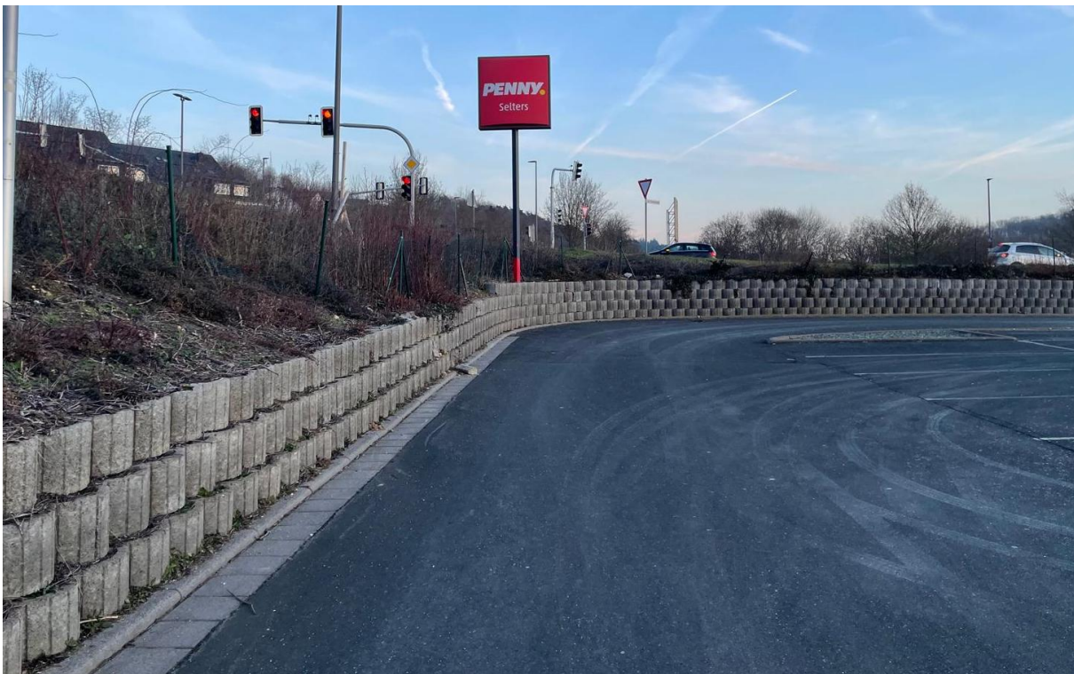
Abb. 12: Böschung/Stellplätze mit Blick auf B8 Kreuzung, Kraus 2026
