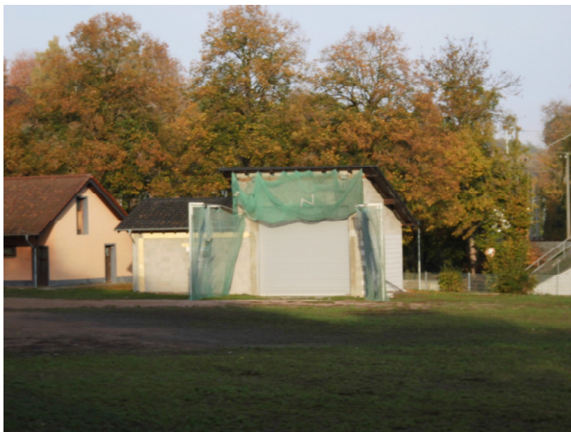
Abb. 7: Blick auf die "Werferanlage Freifläche- Detail Ballfangnetze" vom Plangebiet aus. Quelle: SLESchönherr, 17.10.2018
