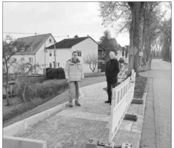
Bürgermeister Bernd Hartmann und Bauamtsleiter Benjamin Zabel zeigen sich sichtlich erfreut über die Fertigstellung des ersten Bauabschnitts.
