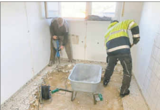
Im Rahmen eines Arbeitseinsatzes musste der durchnässte Estrich abgestemmt werden.
