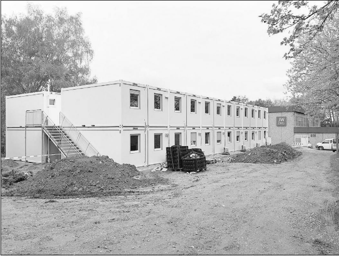
Wohncontainer zur vorübergehenden Unterbringung von Bauhelfern
