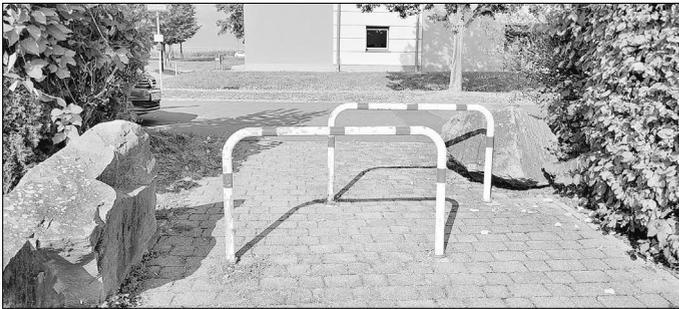
Das Foto zeigt das sog. Drängelgitter in seinem jetzigen Zustand. Entgegen der Empfehlung für Radverkehrsanlagen ERA 2010 überlappen sich die beiden Gitter und es werden die vorgeschriebenen Gitter-Abstände deutlich unterschritten.
